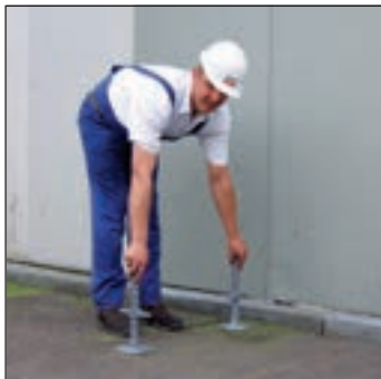
Gewindefußplatten aufstellen
