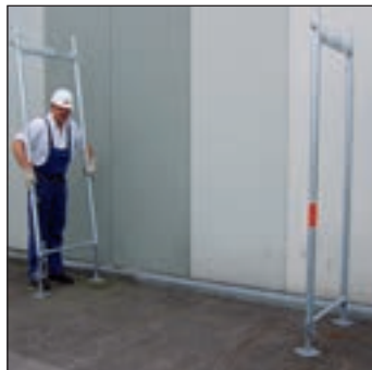
Vertikalrahmen aufstecken
